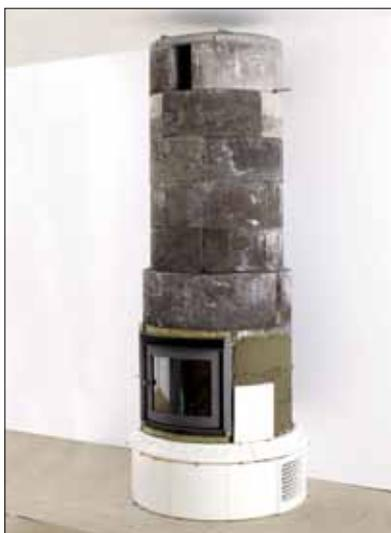
**5. УКЛАДКА ПЛИТКИ.** Можно использовать обычный плиточный клей. Всё укладывается на свои места, и печь приобретает окончательный вид.
