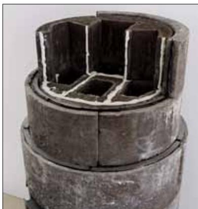
**3. ДЫМОВЫЕ КАНАЛЫ.** На рисунке ясно видны длинные каналы дымохода, благодаря которым печь эффективно накапливает тепло.
