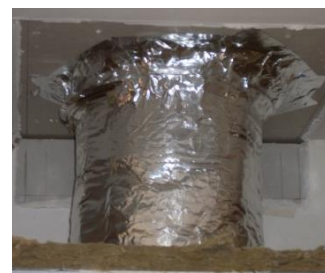
Дымоход с облицовкой
